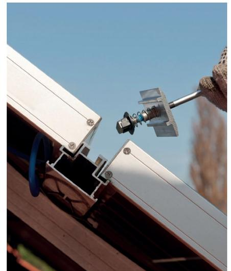
Kleines Detail, überzeugende Wirkung: Die innovative Verdrehsicherung arretiert mit einem Handgriff die Klemme im Profil.
